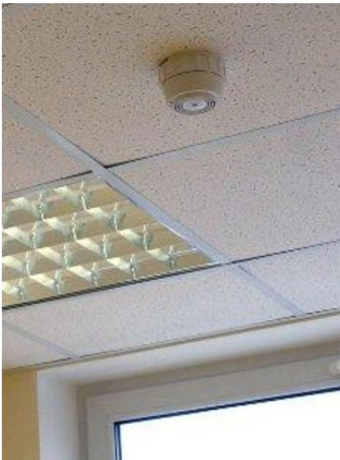
Пожарный датчик (дымовой оптико-электронный извещатель) ИП-212 предназначен для раннего обнаружения загорания, сопровождающегося появлением дыма небольшой концентрации в закрытых помещениях. Дымовой извещатель ИП-212 способен работать совместно с GSM сигнализацией «Радиус-5» для предупреждения о возгорании в квартире, даче, гараже, офисе и во многих других закрытых помещениях.
